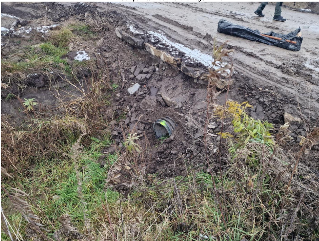
F 78 Skrzyżowanie Rowu Natolińskiego z rowem bez nazwy, widok na E w stronę rozlewiska Wn15 – spadek terenu w stronę rozlewiska – brak możliwości przepływu wód
