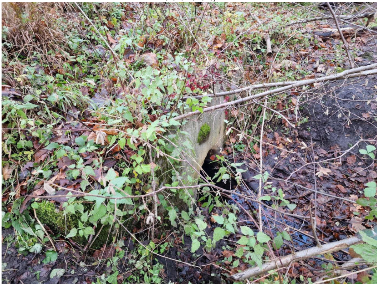
F 48 Wlot do kanalizacji f600 uchodzącej do Rowu Natolińskiego (część wód mogących zasilać Rezerwat została skanalizowana)
