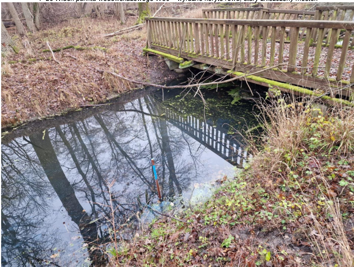
F 26 Widok punktu wodowskazowego W30 – wyraźne koryto rowu, stary zniszczony mostek
