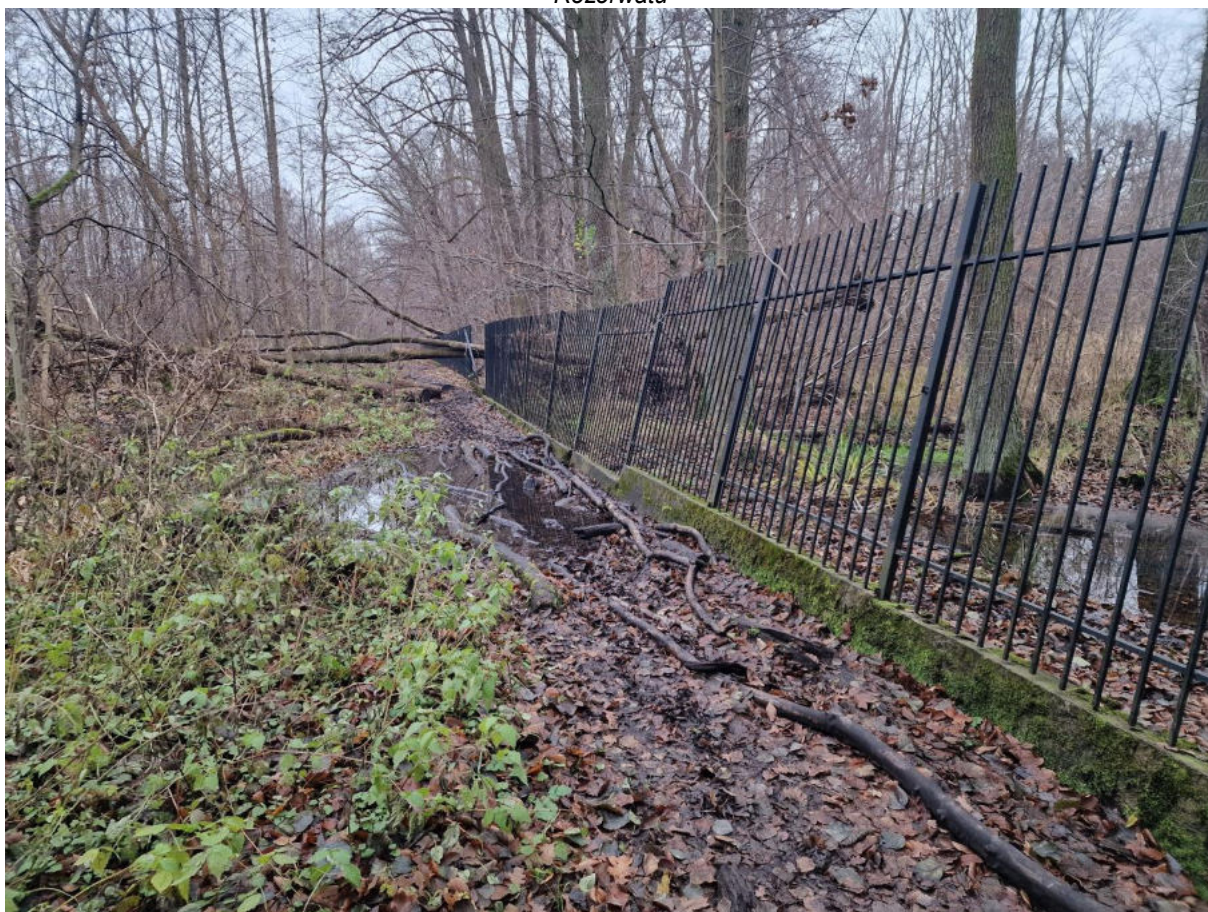
F 6 Brak rowu, rozlewisko od strony zewnętrznej i wewnętrznej Rezerwatu, brak przepustu pod ogrodzeniem Rezerwatu
