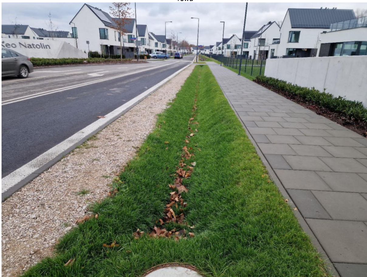
F 80 Rów wzdłuż ul. Pod Dębami – właściwy rów R-P6 został skanalizowany i przebiega pod dnem przedstawionego rowu
