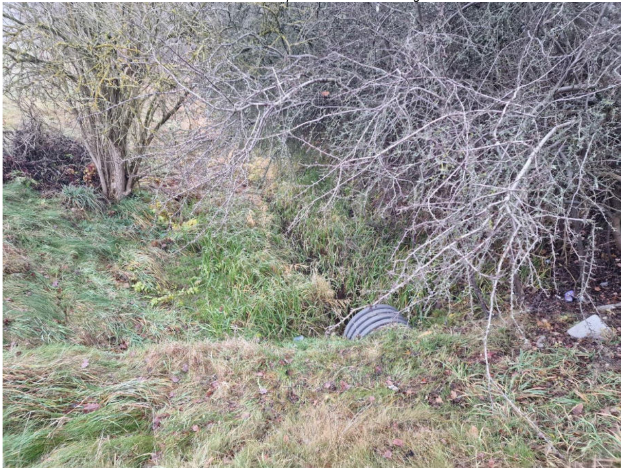
F 48 Wlot do kanalizacji f600 uchodzącej do Rowu Natolińskiego (część wód mogących zasilać Rezerwat została skanalizowana)
